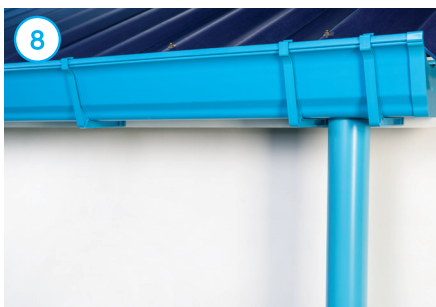
8. หลังจากการติดตั้งเสร็จ ควรทดสอบการระบายน้ำ พร้อมทั้งเช็กทำความสะอาด ด้วยน้ำฝน หรือน้ำยาล้างจาน
