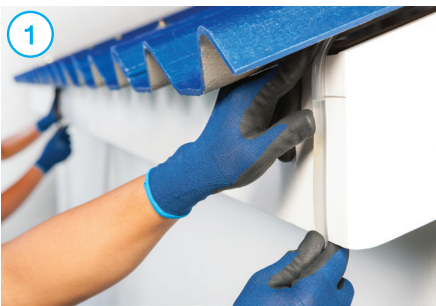
1. ทาระดับบนเชิงชายเพื่อทำการติดตั้งรางน้ำฝน โดยใช้สายยางวัดระดับน้ำ
